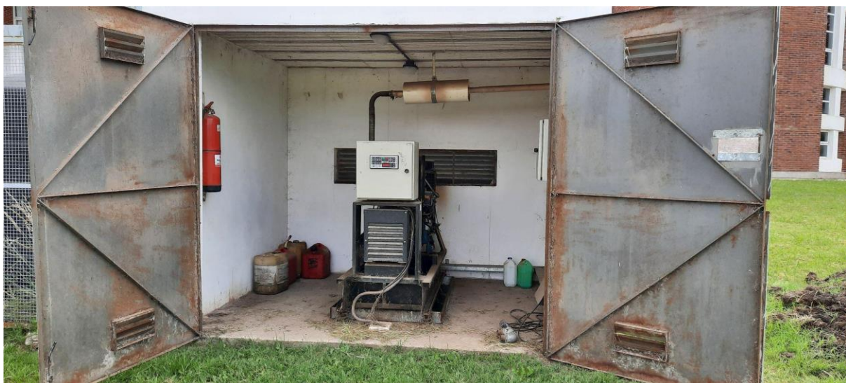
Generador actual, a retirar durante la instalación
