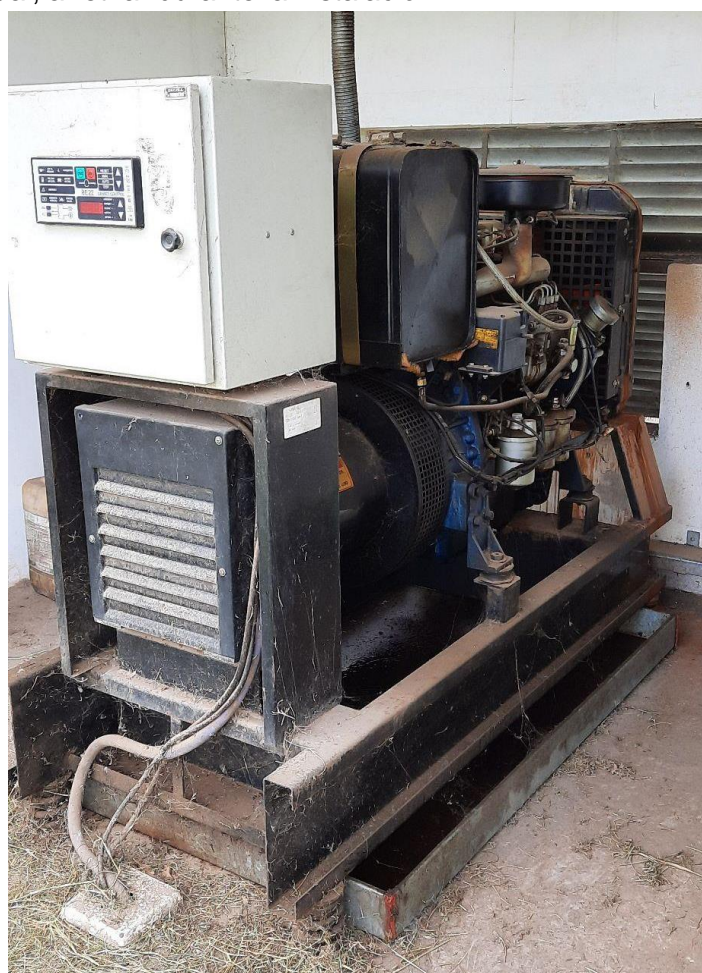
Generador actual, a retirar durante la instalación
