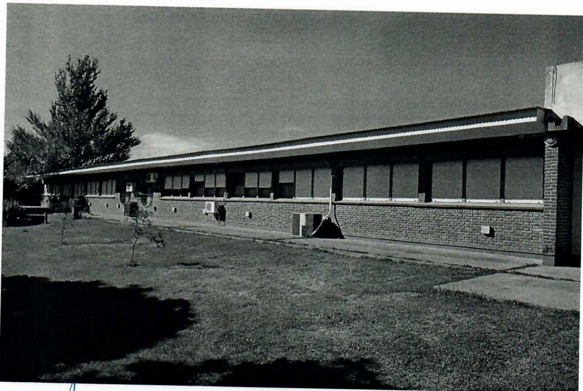
Contrafrente Edificio Aulas Comunes
