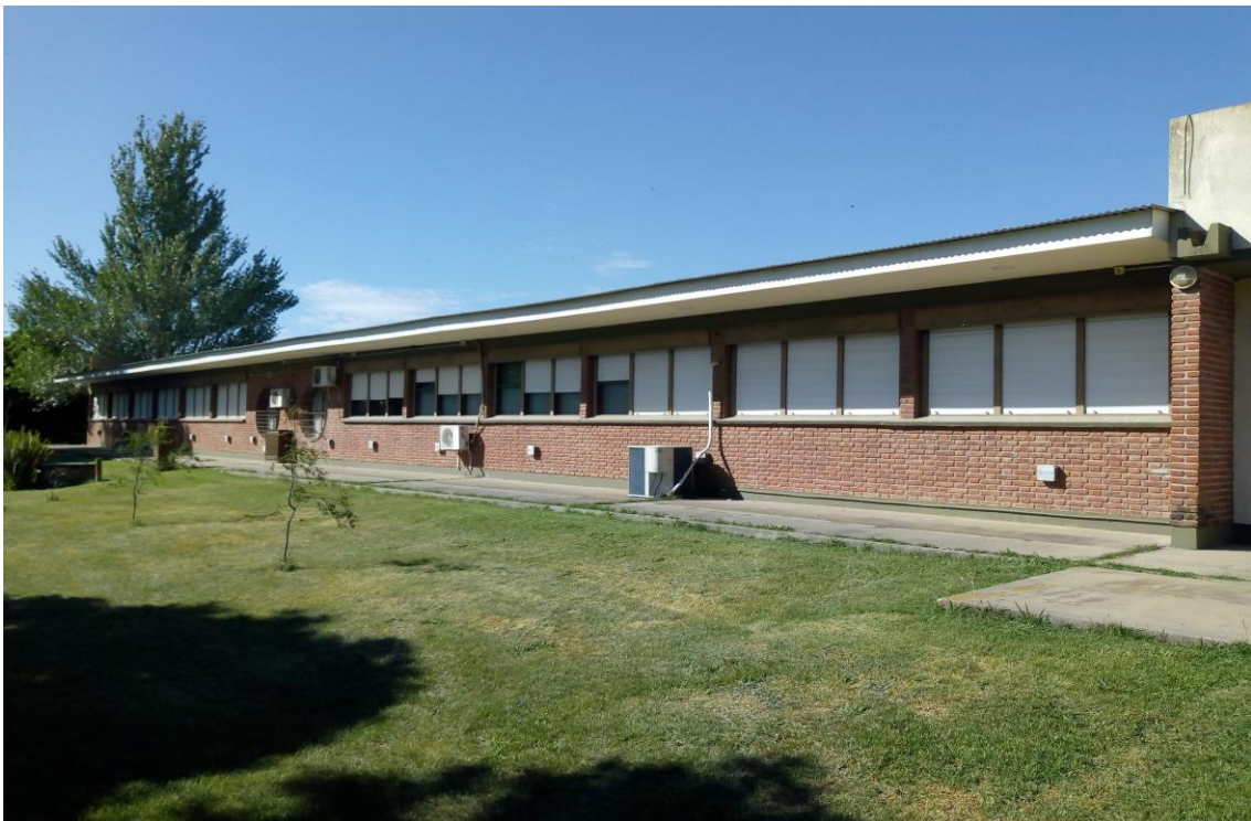
Contrafrente Edificio Aulas Comunes
