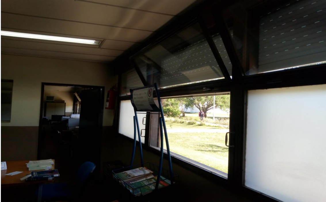
Vista interior biblioteca carpintería existente
